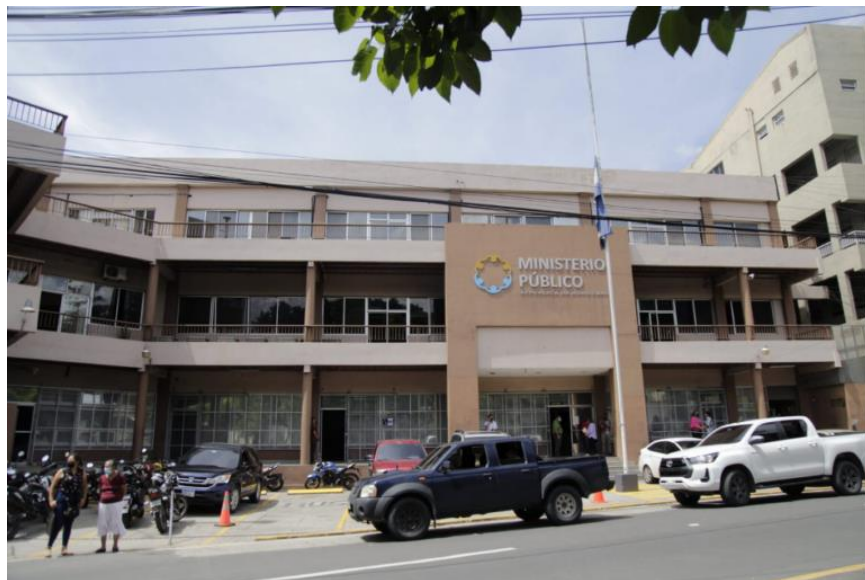
xxix. Fachada do prédio onde funciona o Ministério Público (MP). Tegucigalpa, Honduras. (Foto: ContraCorriente / Fernando Destephen)
