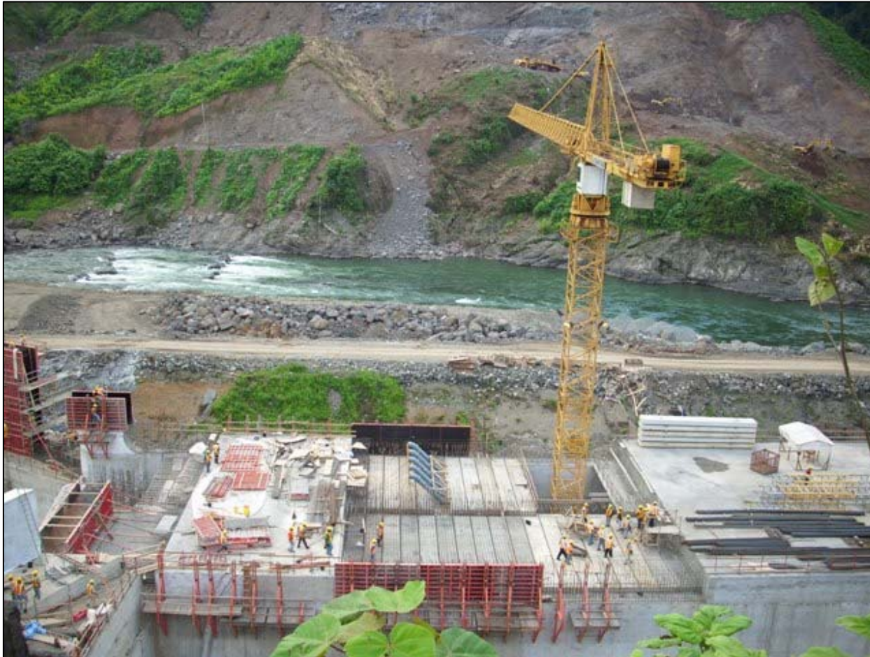
Un sitio de obras para la construcción del la represa Chan 75. Fuente: Prensa Indígena, 21 jun. 2009.
